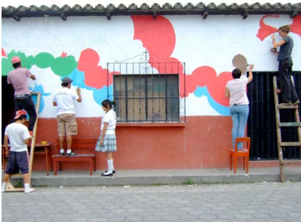
Außen wie innen musste neu gestrichen werden.
